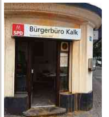
Farbverschmutzungen am Bürgerbüro Kalk Foto: Mauritz
