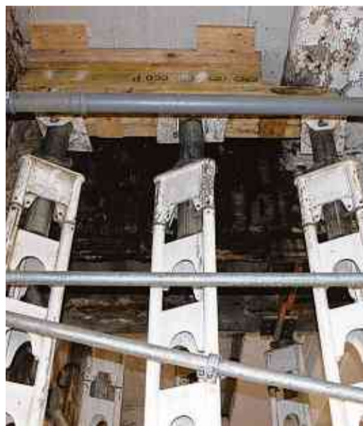
Notstützen innerhalb der Brücke (l.). Die Diskussion lockte etwa 200 interessierte Bürger in die Mülheimer Stadthalle. Fotos: Uwe Schäfer
